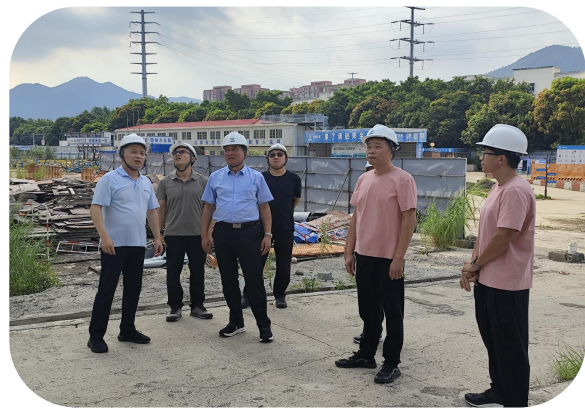
2025年9月29日 上海宝信软件股份IDC领导一行莅临项目参观交流
